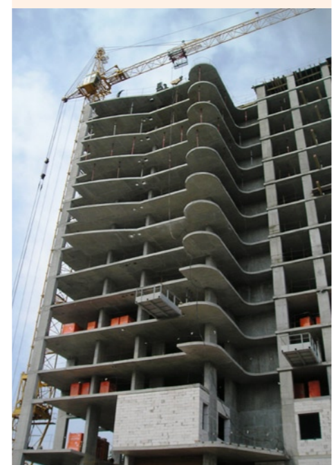
Mitmekorruselise elamu välisseinte ehitus AEROC EcoTerm Plus plokkidest Kiievis
