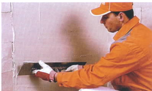
Õhukese kihina kantakse KAM armeerimisseguga, mis sisaldab armeerivat polüpropüleenkiudu.
