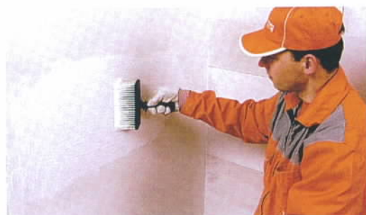
Kuivanud armeerimismördi kihi peale kantakse krunt PG.
