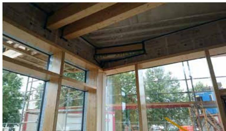
Ненесущие наружные стены с трех сторон здания были сложены из блоков Aeroc Hard, обладающих хорошей воздухопроницаемостью. Проемы в здании, как это свойственно домам с низким электропотреблением, были заполнены трехслойными стеклами – как деревянные окна, так и окна из алюминиевого профиля.
