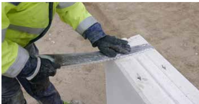
Крепление анкером и фрезеровка углублений
