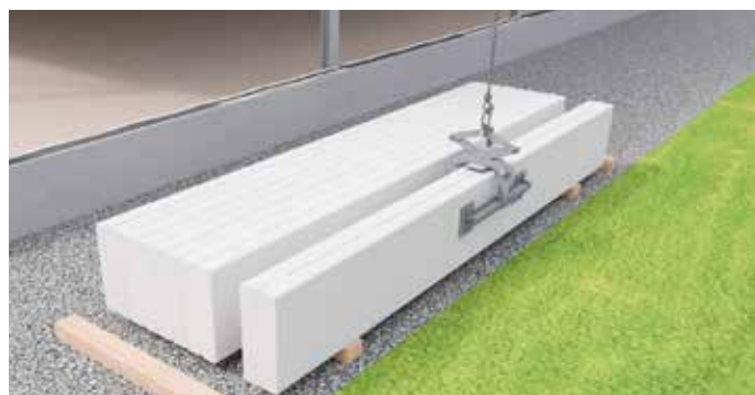
Подъемное устройство должно располагаться по середине панели
