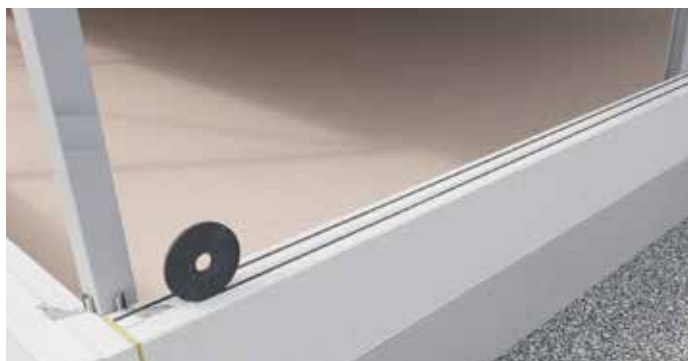
Установка с помощью уплотняющей ленты
