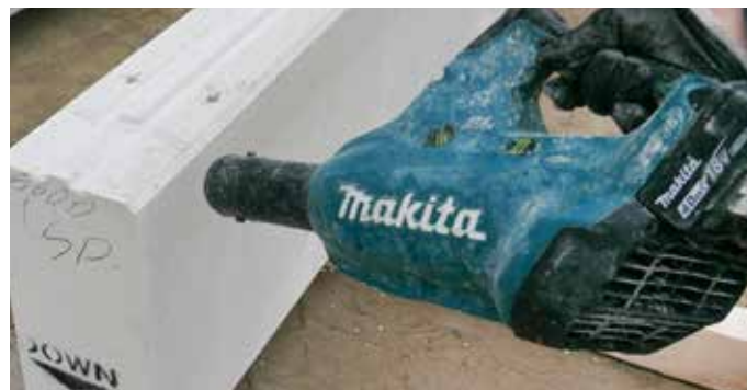
После фрезеровки очистить поверхность панели от мусора
