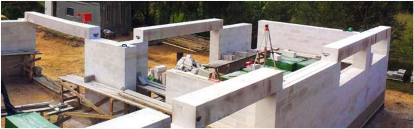
Монтаж армированных перемычек.
