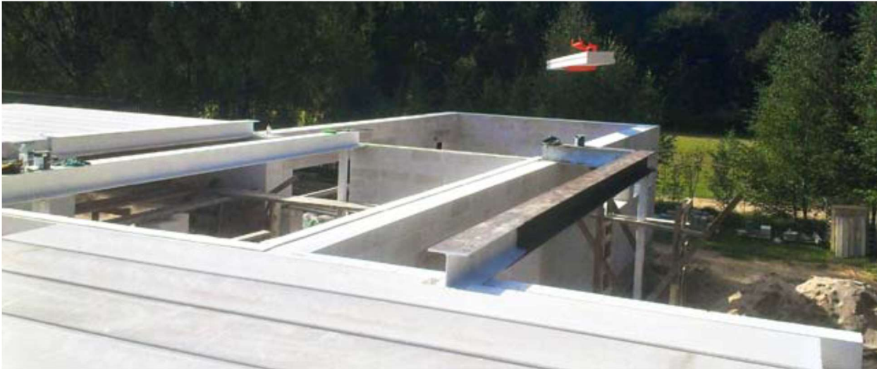
Монтаж панелей перекрытия.
