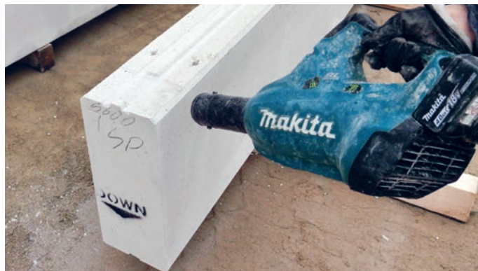
Pärast freesimist puhasta paneeli pind lahtisest purust
