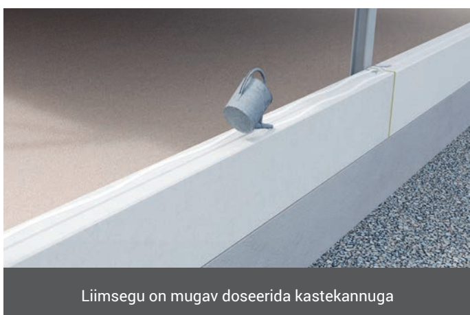
Paigaldamine tihenduslindiga
