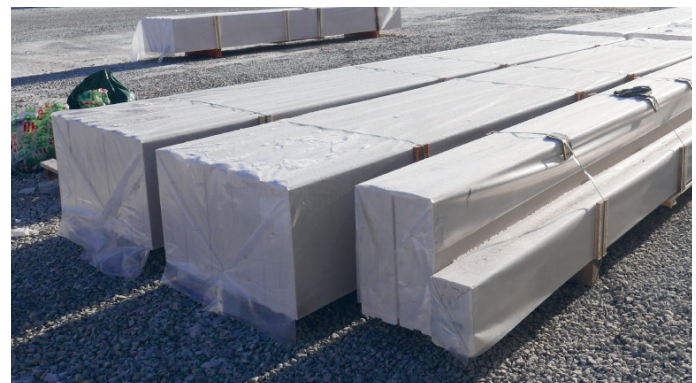
Objektile toodud paneelid peavad olema sademete eest kaitstud
