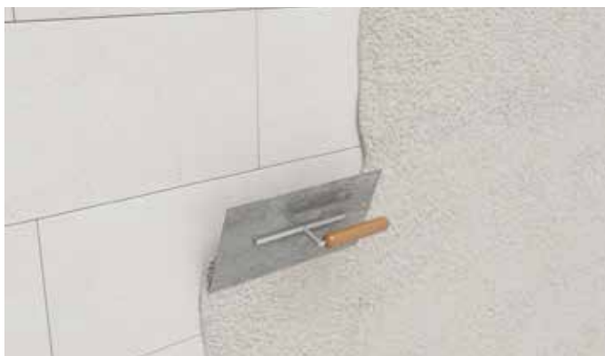
Нанесение штукатурки вручную
