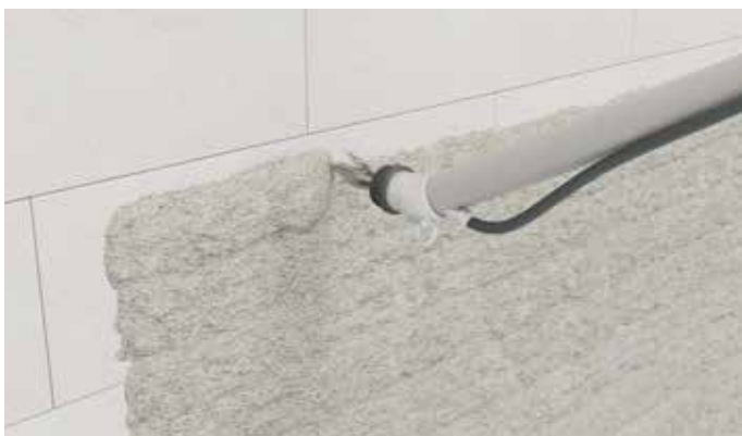
Нанесение штукатурки при помощи насоса
